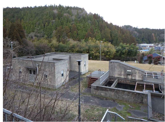
急速ろ過池上屋
