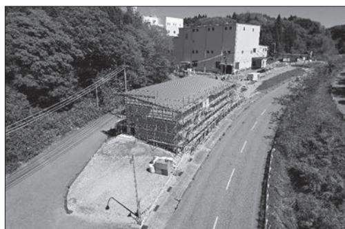
【建設中の資源化物貯留棟と工場棟】
