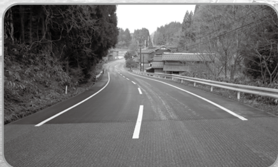
道路災害復旧事業
