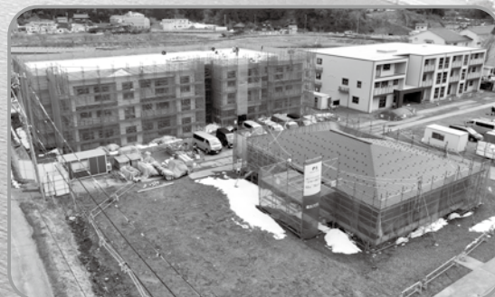
災害公営住宅整備事業
