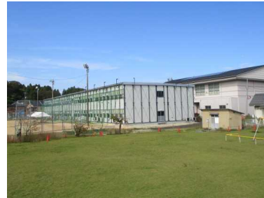
穴水小学校仮設校舎
