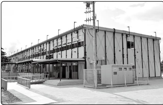
【穴水小学校仮設校舎】
