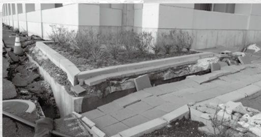
役場庁舎の被災箇所を修繕
