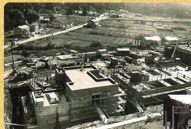
昭和50年頃／穴水町此木インター建設工事(昭和53年／能登縦貫道・此木-中島町横田間15.9km開通、昭和57年／能登有料道路・此木-金沢市薬師町82.9km全線開通)
