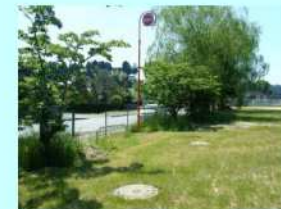
耐震性貯水槽
